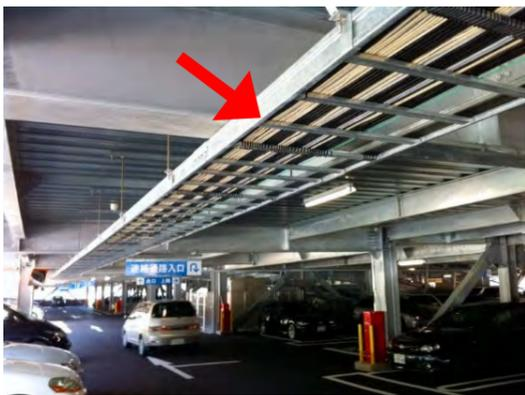
ケーブルラックの例（重量 100kg/m 程度）
