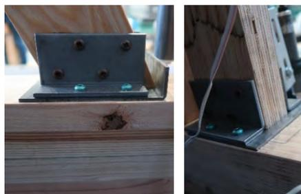
**[横架材-支持材間の鋼板]**
